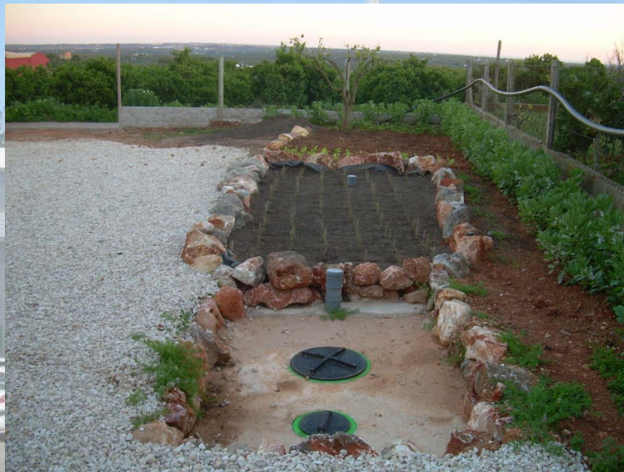
FOSSA 2300 L + TRINCHEIRA INFILTRANTE
